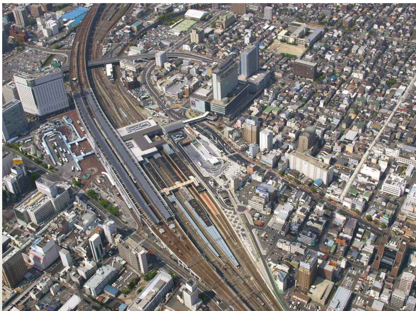
岡山駅周辺整備完成
