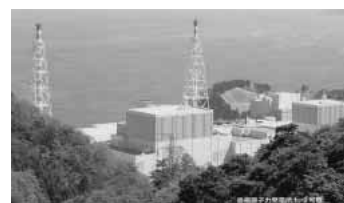
島根原子力発電所
