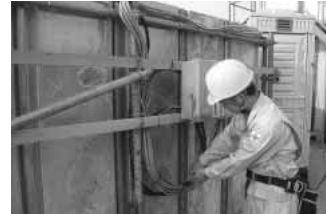
配線実習：三恭電設
