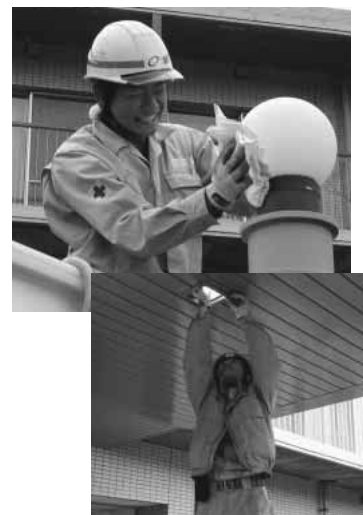
(株)中電工 器具点検・清掃中
