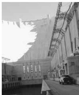
フーバーダム水力発電所 (発電出力:2,080MW)
