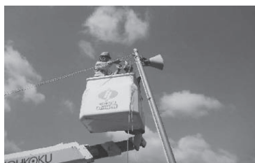
高所作業を初体験：報国電設
