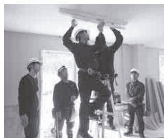
照明器具取付：(株)木多電気設備
