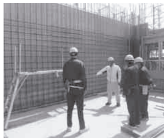
建設現場視察：旭電業(株)
