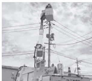
高所作業体験：三恭電設(株)
