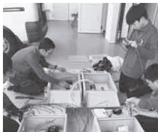
分電盤実習：カジノン(株)
