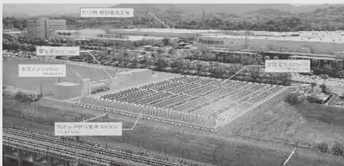
実証施設では広大な敷地に太陽電池（約570kW）、蓄電池（約1.1MWh）、2列99台も並べた純水素型燃料電池（5kW×99台＝495kW）及び巨大な水素タンクを見学し説明を受けました。また燃料電池工場の作業も見学させて頂きました。
